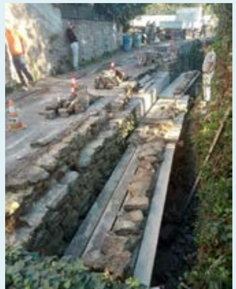
Réfection parapet et mur route de Gaude
