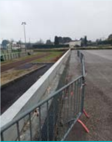
Réalisation d'un muret stade de la Mure
