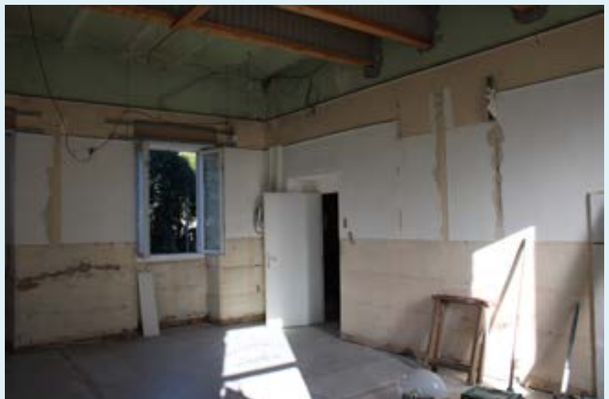
Travaux d'aménagement d'un cabinet médical
