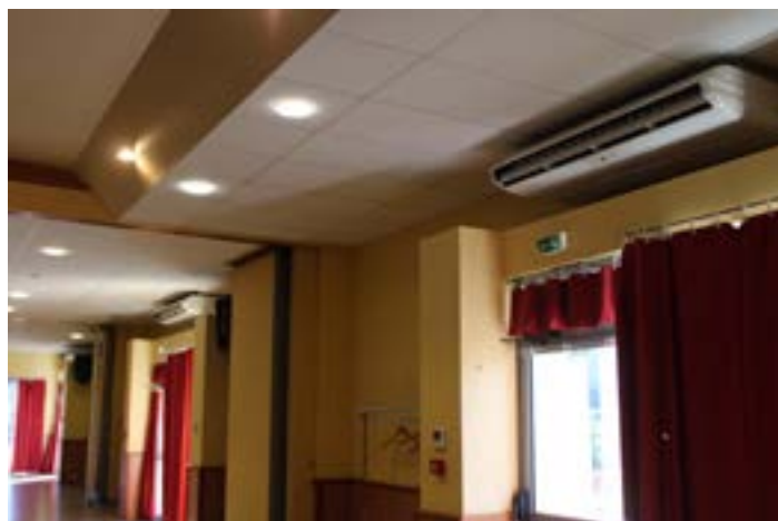
Installation de climatiseurs réversibles à l'Espace M. Champel
