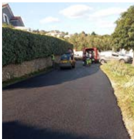
Travaux de voirie chemin des Rimbeaux
