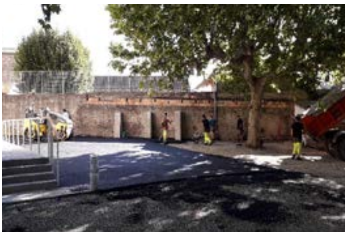
Aménagement du parking de la Maison pour Tous
