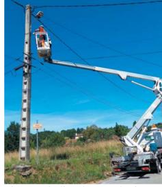
Désormais obsolètes, les ampoules à vapeur de mercure sont remplacées par de nouveaux luminaires utilisant la technologie LED
