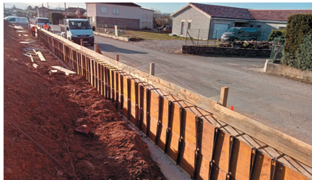
Aménagement et sécurisation de la Route des Champs (Phase 2)
