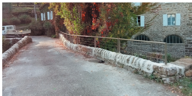
Sécurisation du Pont-de-Rigaud : aménagement d'un garde-corps
