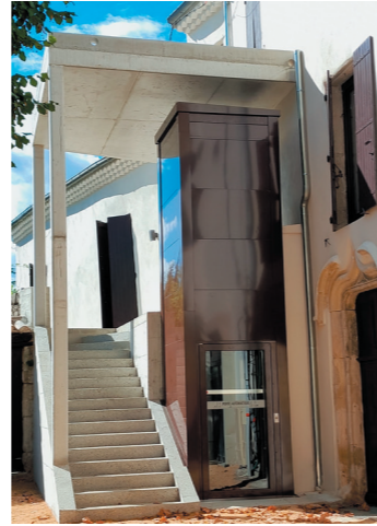
Maison des Associations : Installation d'un ascenseur
