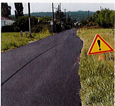
Réfection de la chaussée Chemin des Brugières
