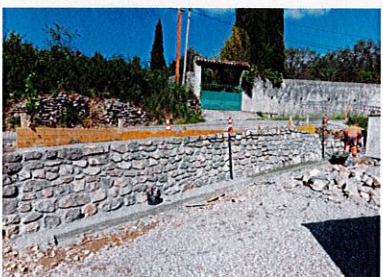
Réfection et sécurisation d'un mur Quartier Néviissac
