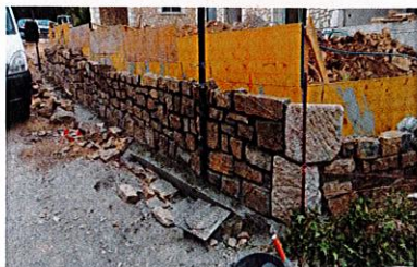
Réfection et consolidation d'un mur Route des Chiffaux
